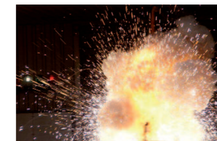
Arc flash 7 kA
